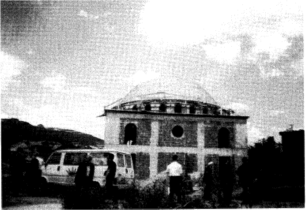
مسجد ستوفالي (تحت الإنشاء) في بريشتنا
