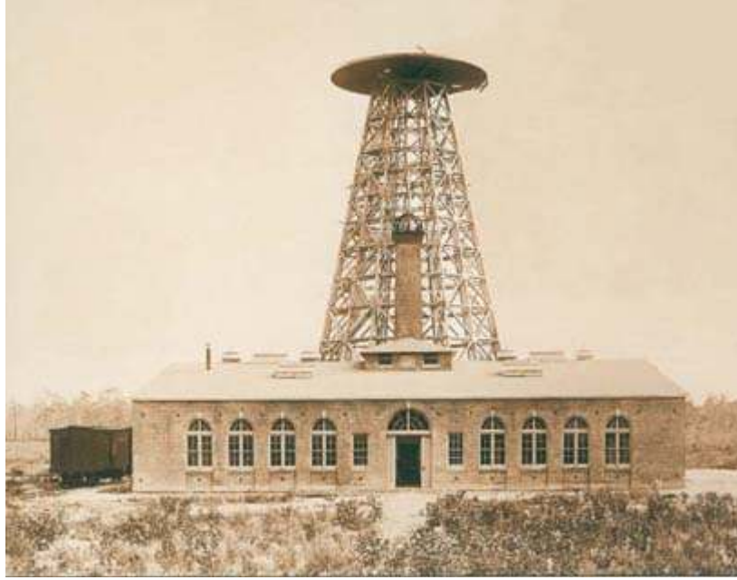
محطة "واردن كليف" في نيويورك لبثّ الكهرباء لاسلكياً
