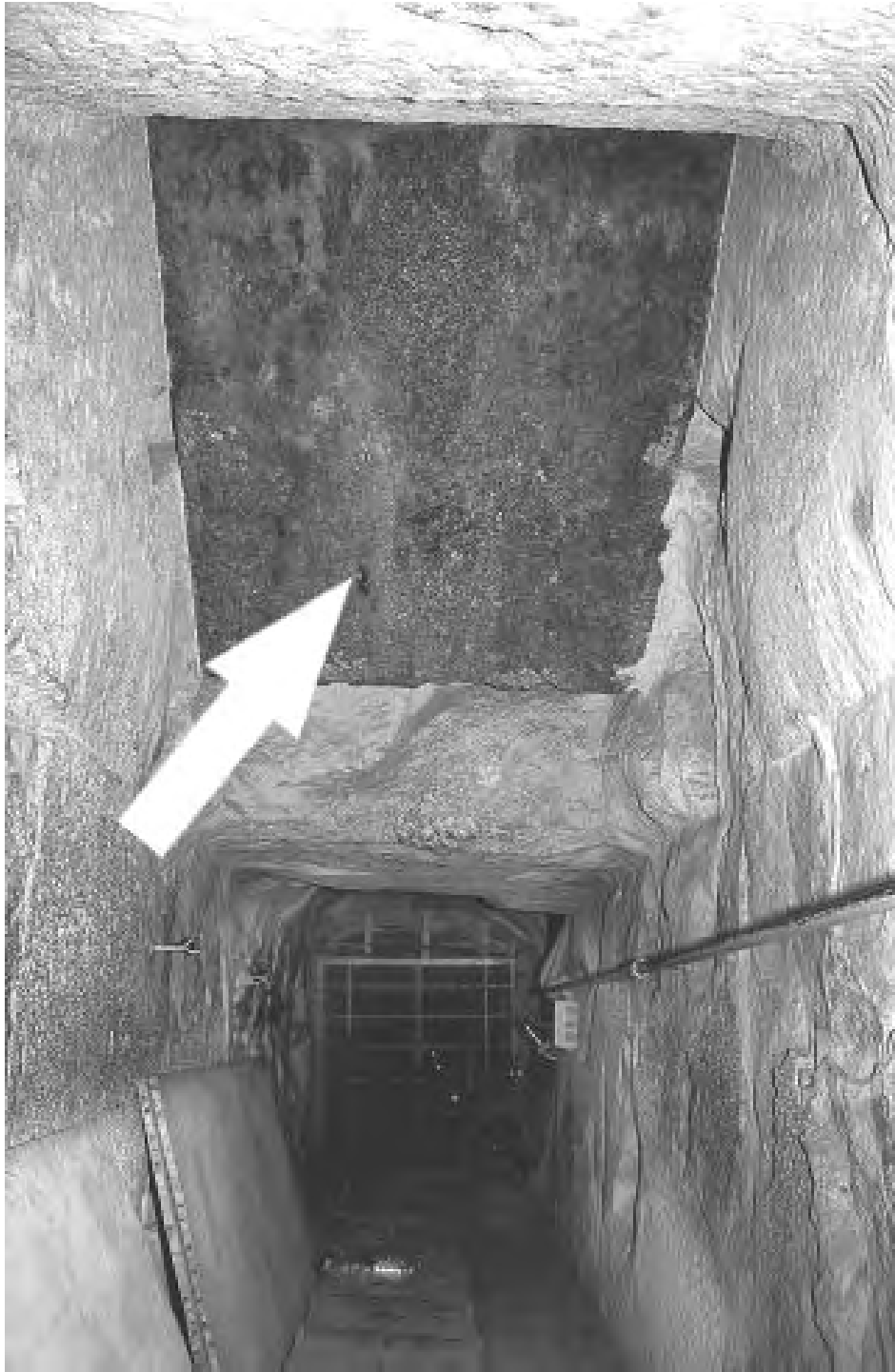
حجر السدادة الغرانيتي (الجيري)، والذي عندما يسقط بعد إرخاؤه، يعمل على سدّ الممر الهابط.
